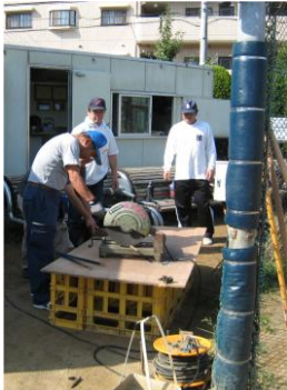
ネットフェンス用鉄杭の メンテナンス
