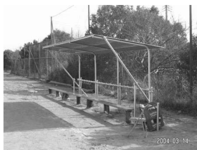
新設ベンチの完成
