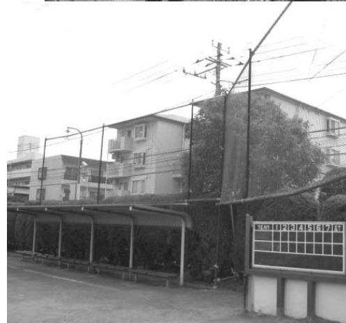
取り付け作業後の一塁側風景
