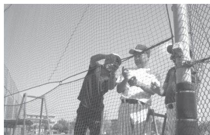
一塁側ファールフェンスネット取り付け
